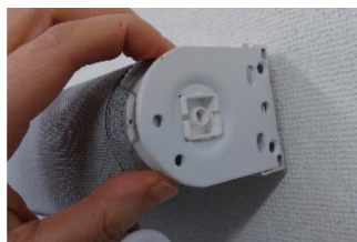
サイドブラケットに丸軸ユニット挿入 (しっかり四角の穴に入っているか確認)
